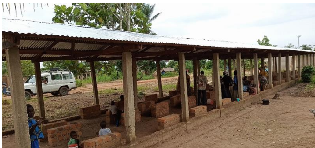
Fig.11 Marché de Bena Manda en phase de construction (Kasaï-Occidental)
